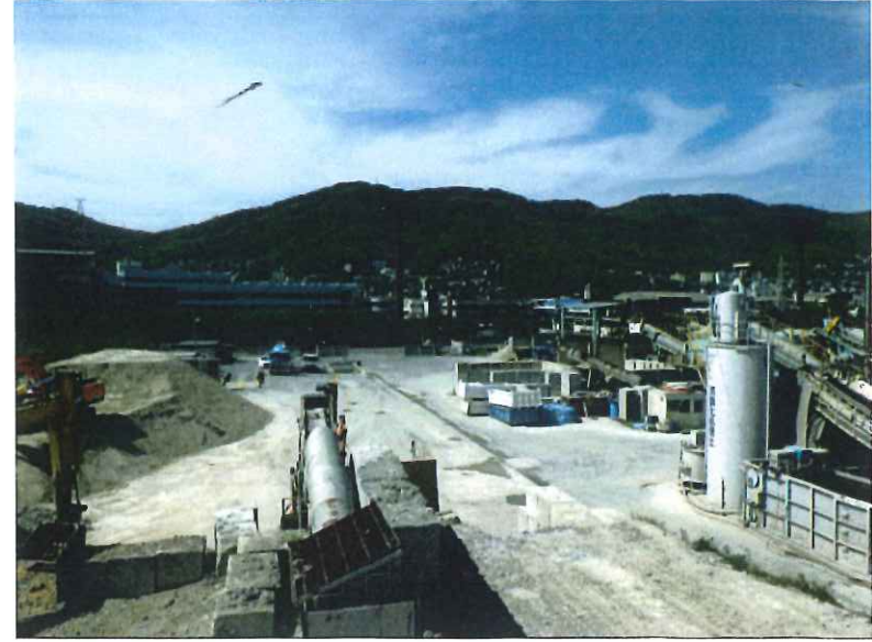
環境施設全景
